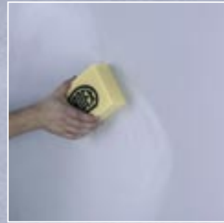
3. Nach einer Stunde wird die Fläche mit einem Schwamm oder Schwammbrett mit Wasser aufgerieben.
