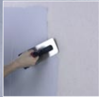
1. Das Material wird mit einer Glättkelle aufgezogen.
