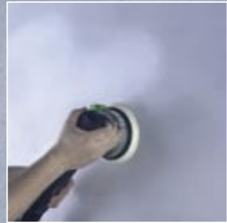
5. Nach ca. 4 – 5 Stunden wird die Oberfläche mit einem Exzenter-schleifer und 120er Schleifpapier poliert.
