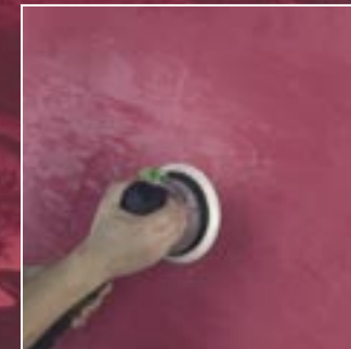
3. Nach ca. 4 – 5 Stunden werden die Spitzen mit einem Exzenter-schleifer und 80er Schleifpapier gebrochen.
