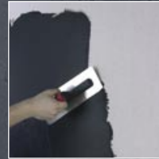
1. Das Material wird mit einer Glättkelle aufgezogen.
