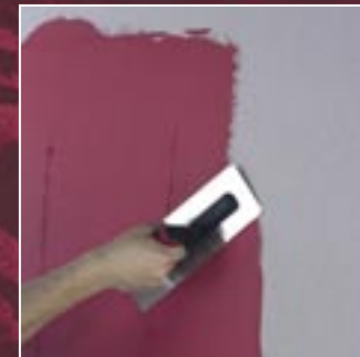
1. Das Material wird mit einer Glättkelle aufgezogen.
